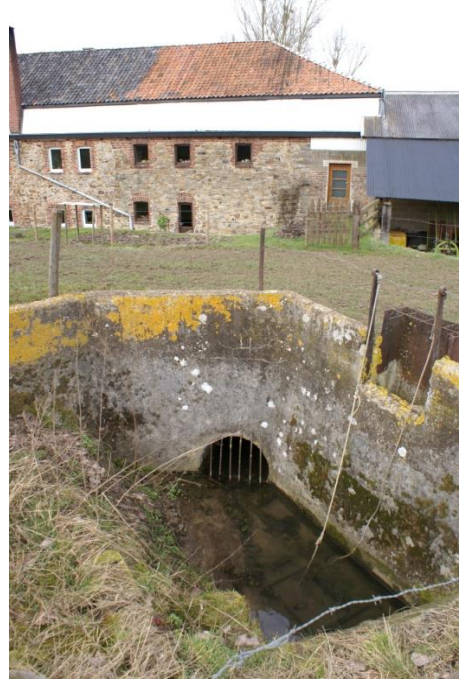
Deze loopt onder de grond, tot aan een buffer. Tot voor kort was hier ook een vijver. De watertoevoer loopt verder onder de grond langs de molen, en dreef het rad aan.
