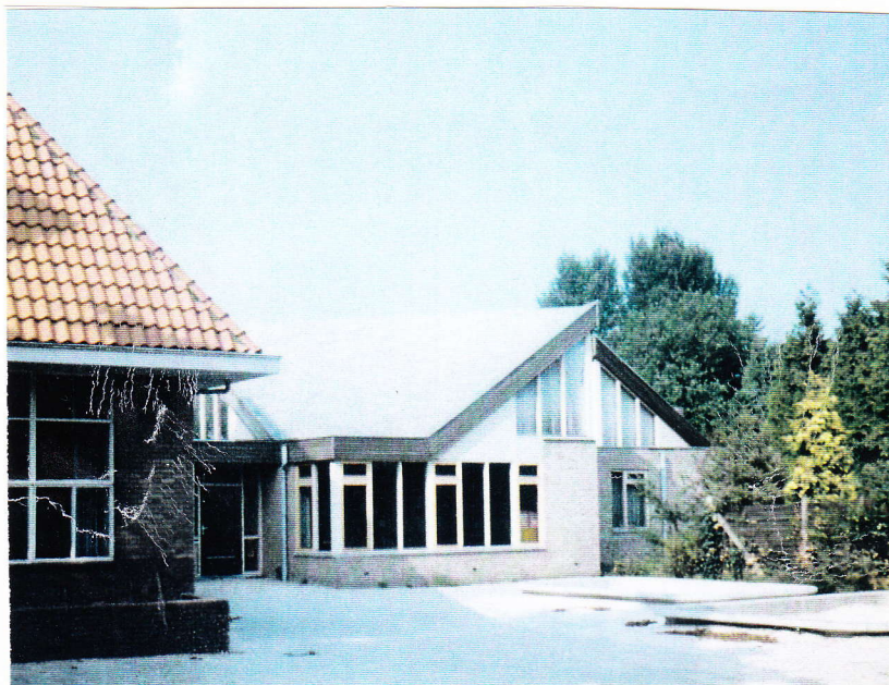
De nieuwe kleuterschool uit 1980 met 2 lokalen van 72 m 2 , die in de plaats kwam voor het houten noodlokaal uit 1962.
